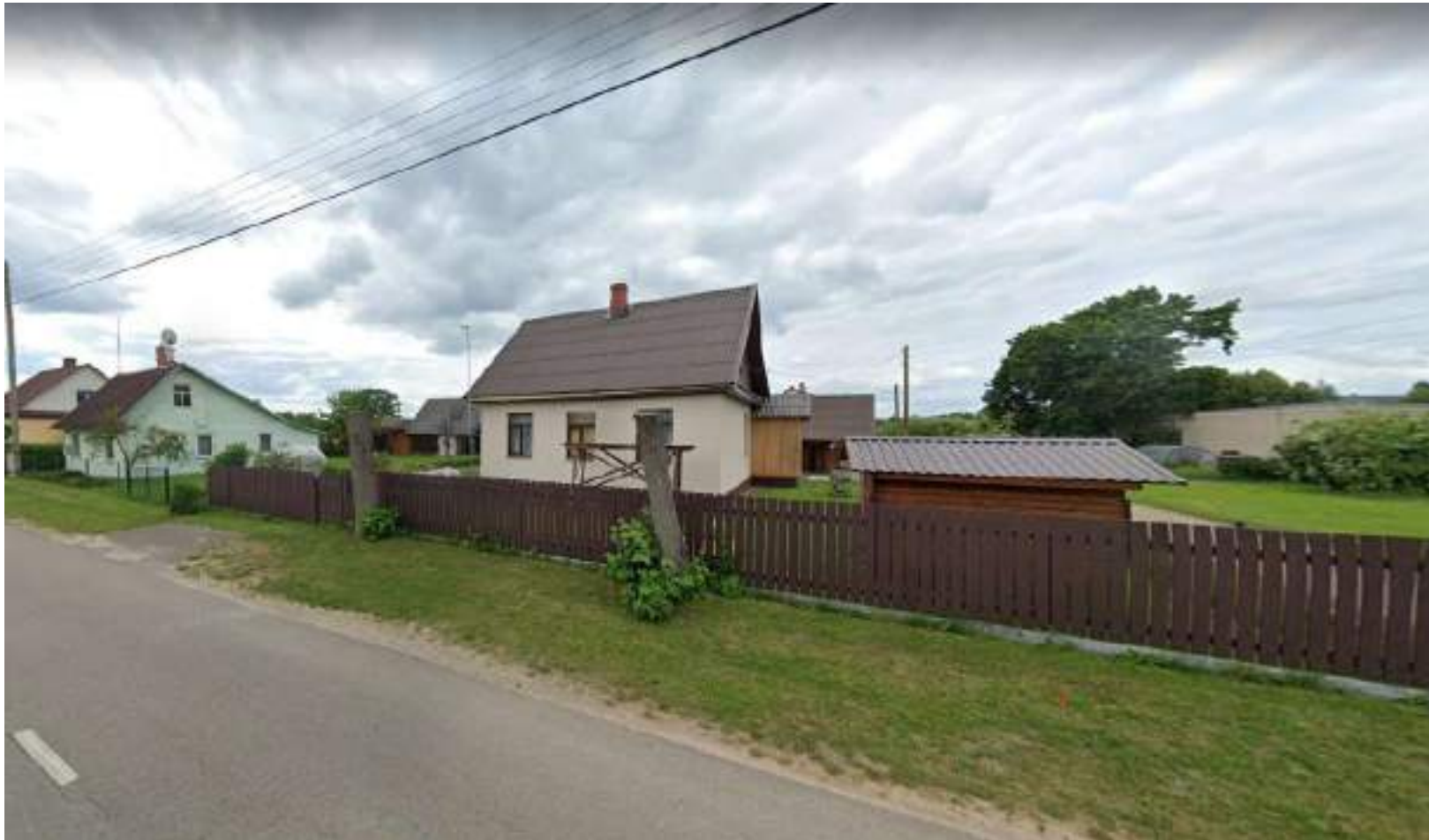
Ozolu iela 4. Vēsturiskās koku rindas brutāls pārrāvums. Ozolu 6. Sānu fasādes piebūve kropļo vēsturisko ēku apjomu. Satelīts uz skursteņa kultūrvēsturiskā telpā neder.
