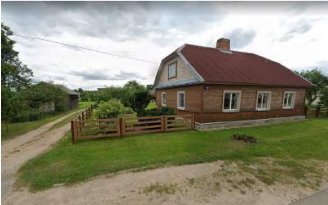
Ozolu iela 9. Izzudusi vēsturiskā jumta kore. Izbūvēts kores nošļaupums. Žoga materiāls un perfekcionisms, kas nav raksturīgs reģionam. Vēsturiski žogam netika likti ēvelēti dēļi. Logu rūtojums neatbilst vēsturiskajam būvniecības stilam.
