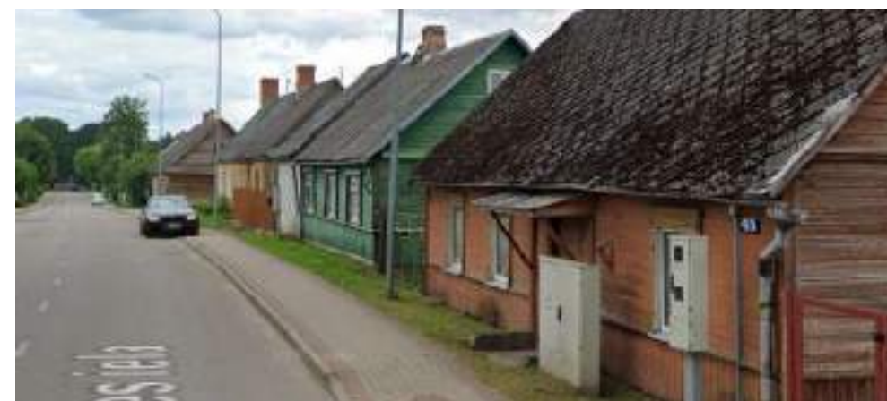
Pilskalnes ielas apbūve
